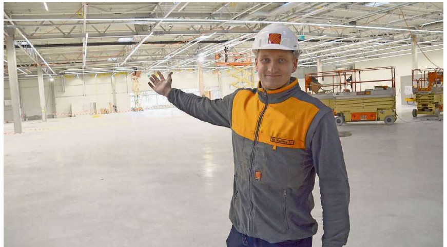
Matthäus Kubica, Marktleiter von Hornbach in Affoltern, zeigt es: Die Halle ist weitgehend fertig und bereit für die Einrichtung. (Bild Thomas Stöckli)
