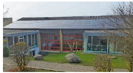
Die PV-Anlage auf dem Primarschulhaus Schachenmatten 2. (Bild zvg.)
