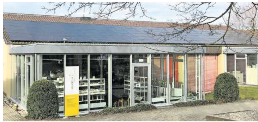
Fotovoltaik lohnt sich auch auf Dächern von Verwaltungen, Schulen – hier die Primarschule Bonstetten. (Bild zvz.)
