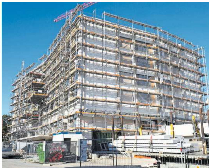
Die Baustelle Seewadel. (Bild zvz.)
