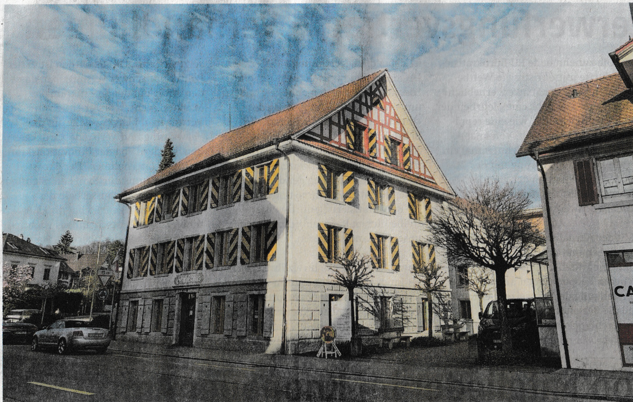
Ab Sommer 2025 benötigt die Stadt dieses Gebäude komplett als Schulraum. Das Familienzentrum muss ausziehen. (Bild lhä)
